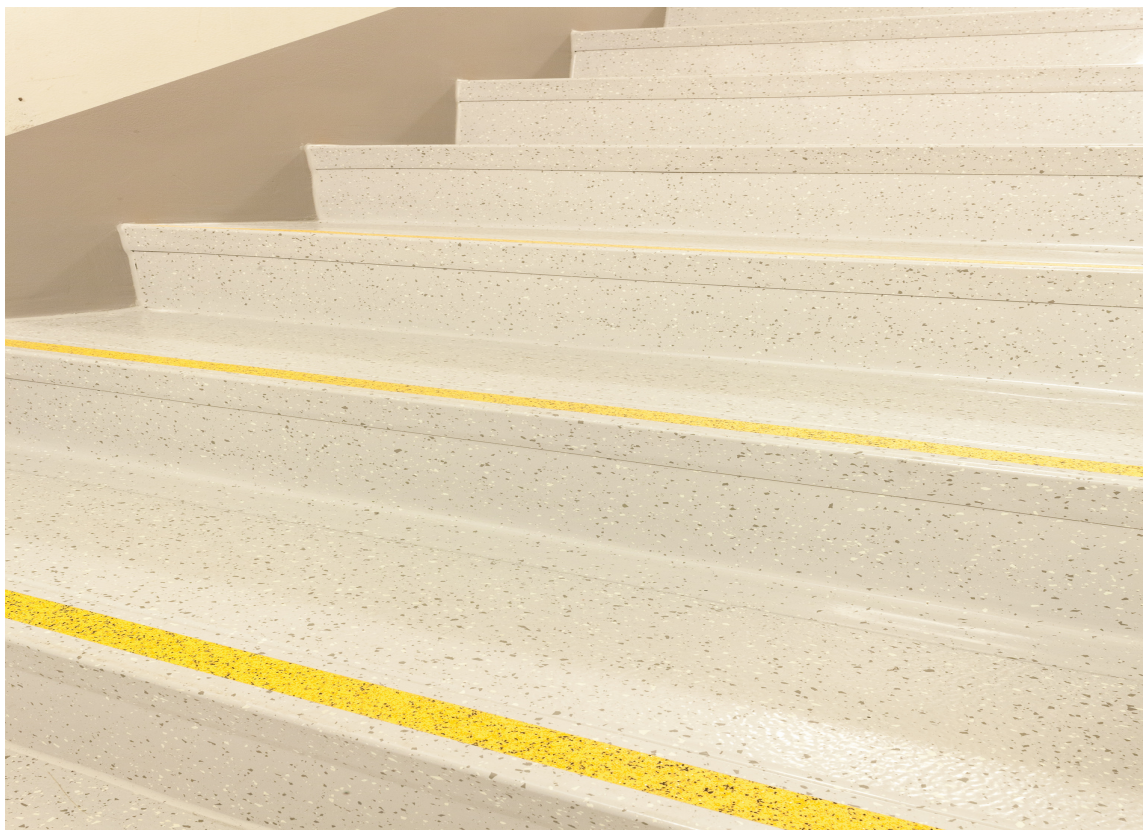
KLIPP OG LIM: Trinnene kommer i tre ulike bredder. Alt fra 1,2 meter til 2 meter og kan klippes til slik at det passer rett inn i trappen. Gummitrinnet festes med tape.
