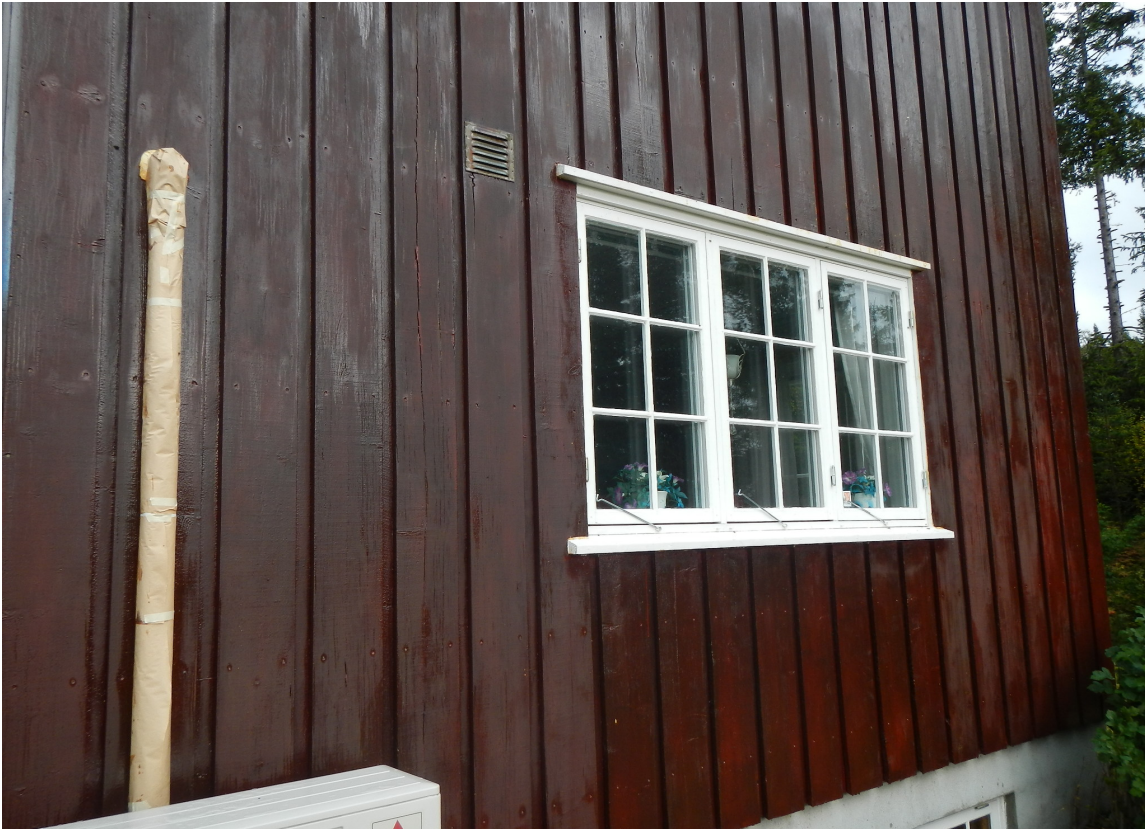
SKJOLDETROLL: Hvis det dannes dugg på en nylig malt flate, vil det oppstå matte skjolder. Disse forsvinner ikke av seg selv, og må males over.
