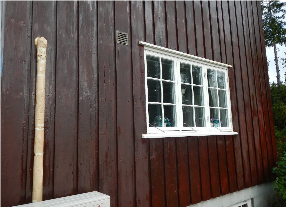
DUGGMATTING: Dugg på fasaden kan være en utfordring når du maler i høstmånedene. Det viser seg som matte skjolder når malingen tørker.
