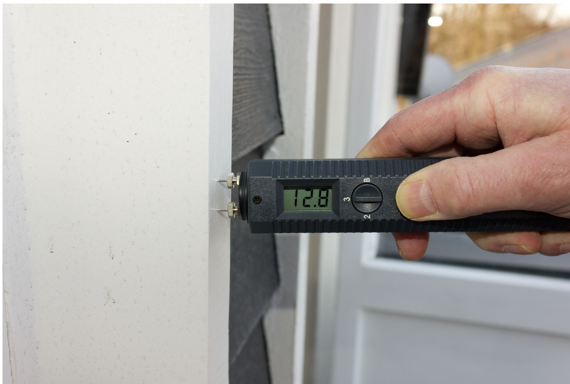
FUKTSJEKK: En fuktmåler er kjekk å ha for å finne ut om treverket er tørt nok til å males.
