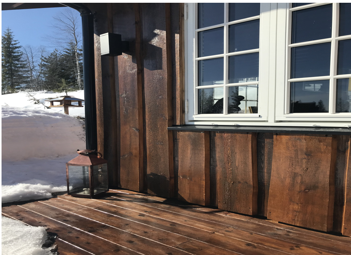
FARGEHARMONI: Tyrilin Tjærebeis får et blankt utseende ved flere strøk. Her er kledningen påført ett strøk i fargen 14 «Mellombrun» og ett andre strøk i fargen 11 «Lys».
