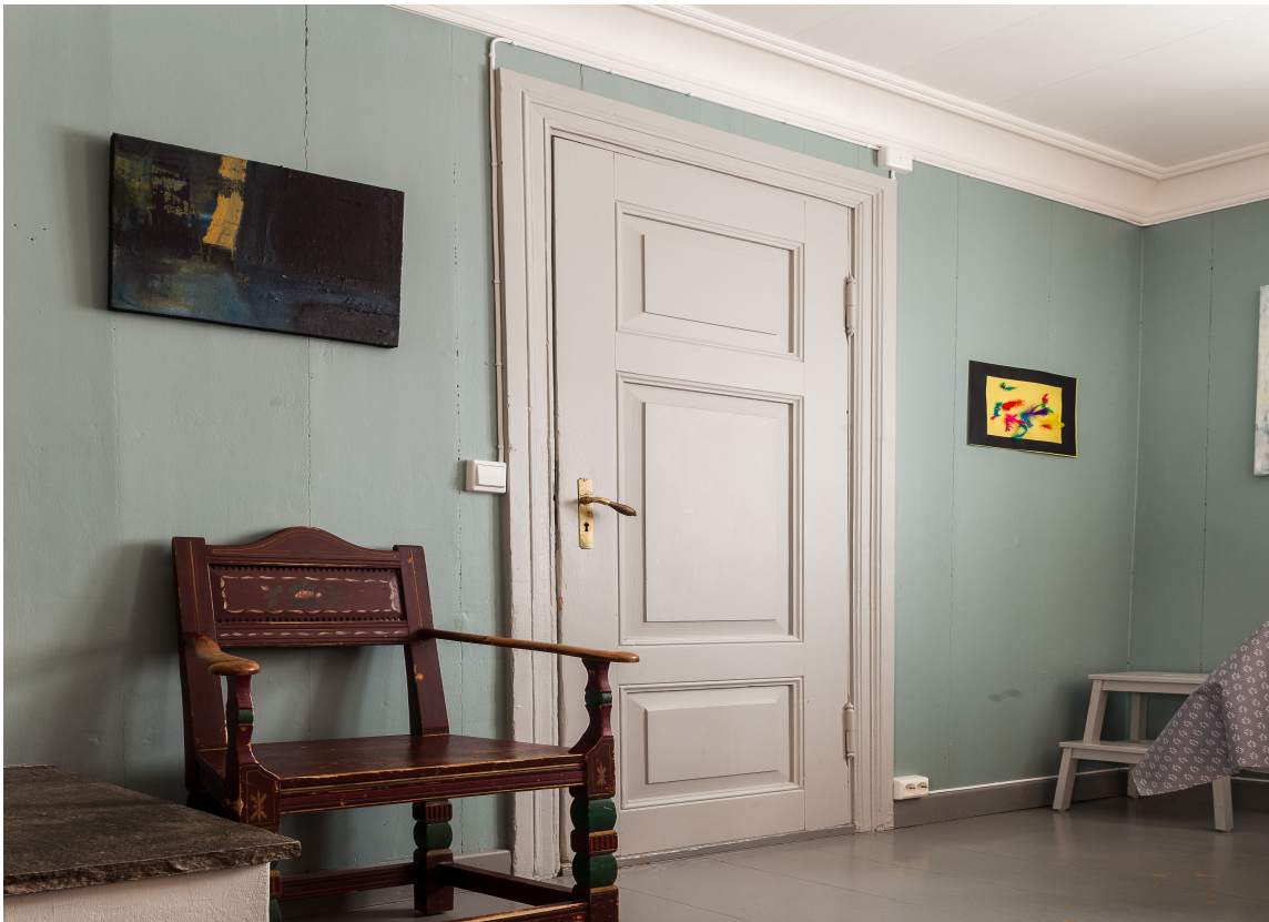
TAKLISTER: De flotte taklistene er nye, men konstruert etter modell av lister i andre rom huset.
