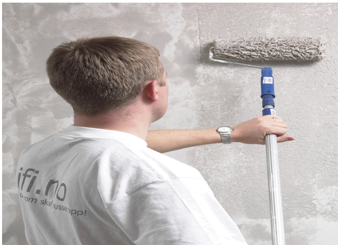
SPARKEL: Sparkel kan påføres med en spesialrulle eller en vanlig grov rull, og slettes med en bredsparkel.
