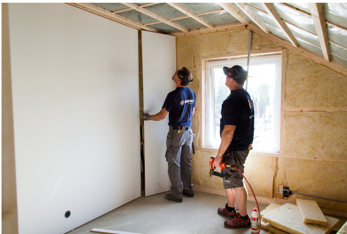
SLETT: Ferdiggrunnede slette veggplater kan monteres på eksisterende vegg eller direkte på stenderverk. I begge tilfeller blir resultatet en slett vegg klar for maling eller tapetsering.
