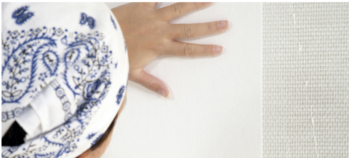
DUK: Fiberduk, også kjent under andre navn, settes opp som tapet og dekker ujevnheter i underlaget.
