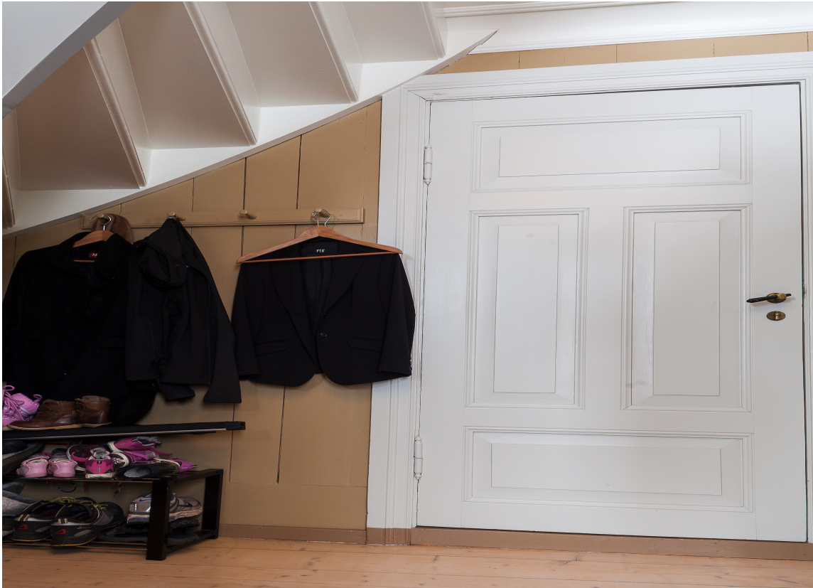
UNDERSIDEN: Undersiden er hvitmalt, akkurat som taket. Da blir trappen lettere og kroken blir lysere.
