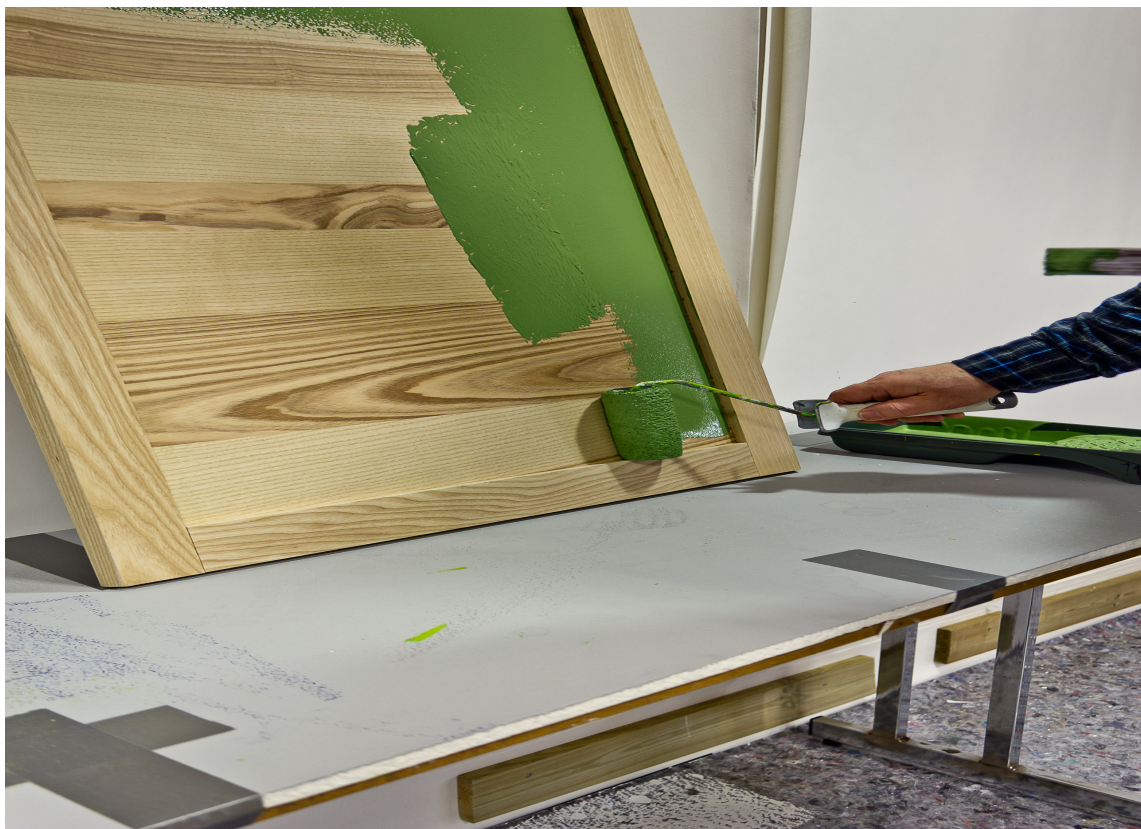
SLIK MALER DU KJØKKENFRONTER: Både grunning og maling påføres best med rull.
