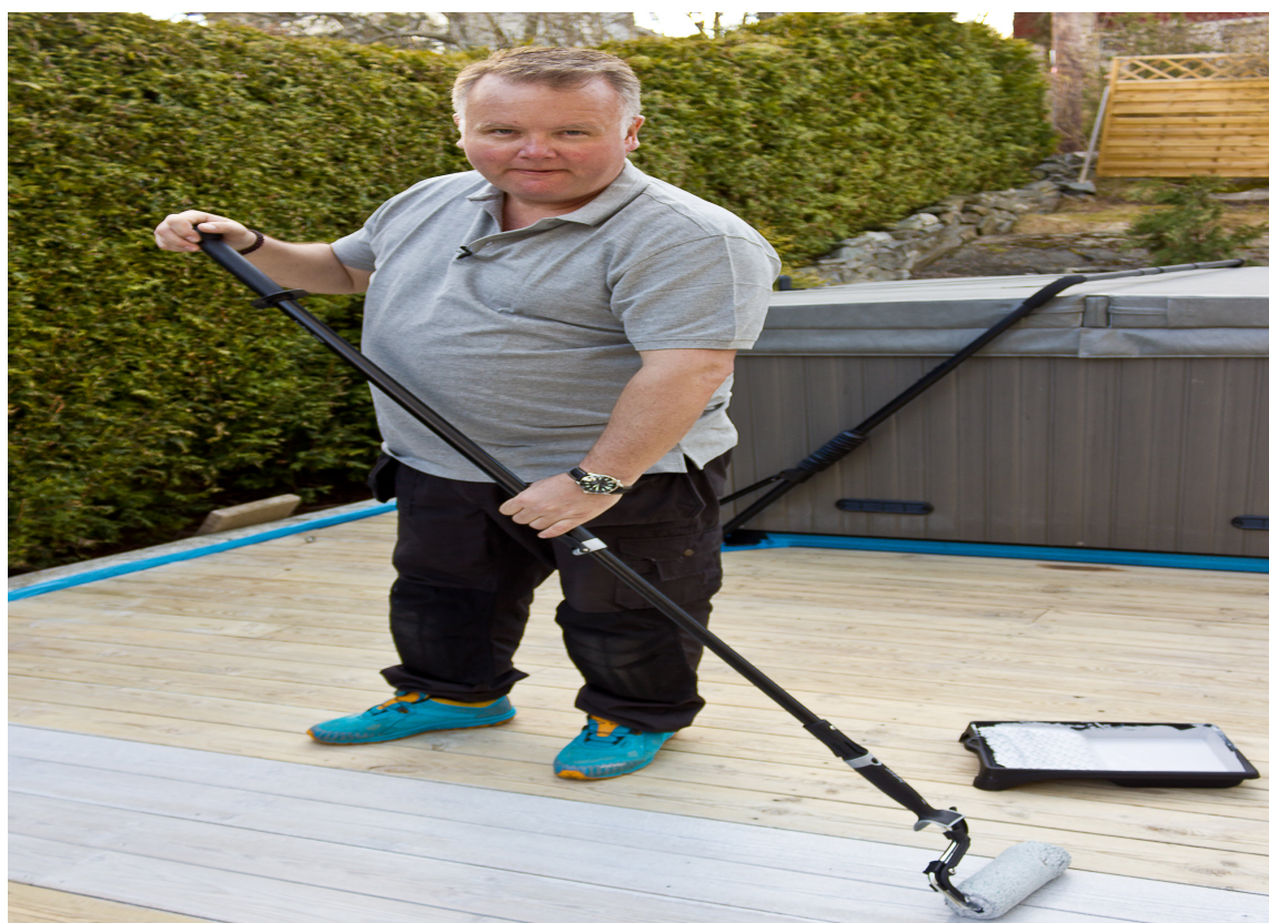
VÅTT-I-VÅTT: – Beisen eller oljen påføres på et par bord av gangen. Arbeidet utføres vått-i-vått, sier Morten Fehn, ansvarlig malermester hos Jordan.
