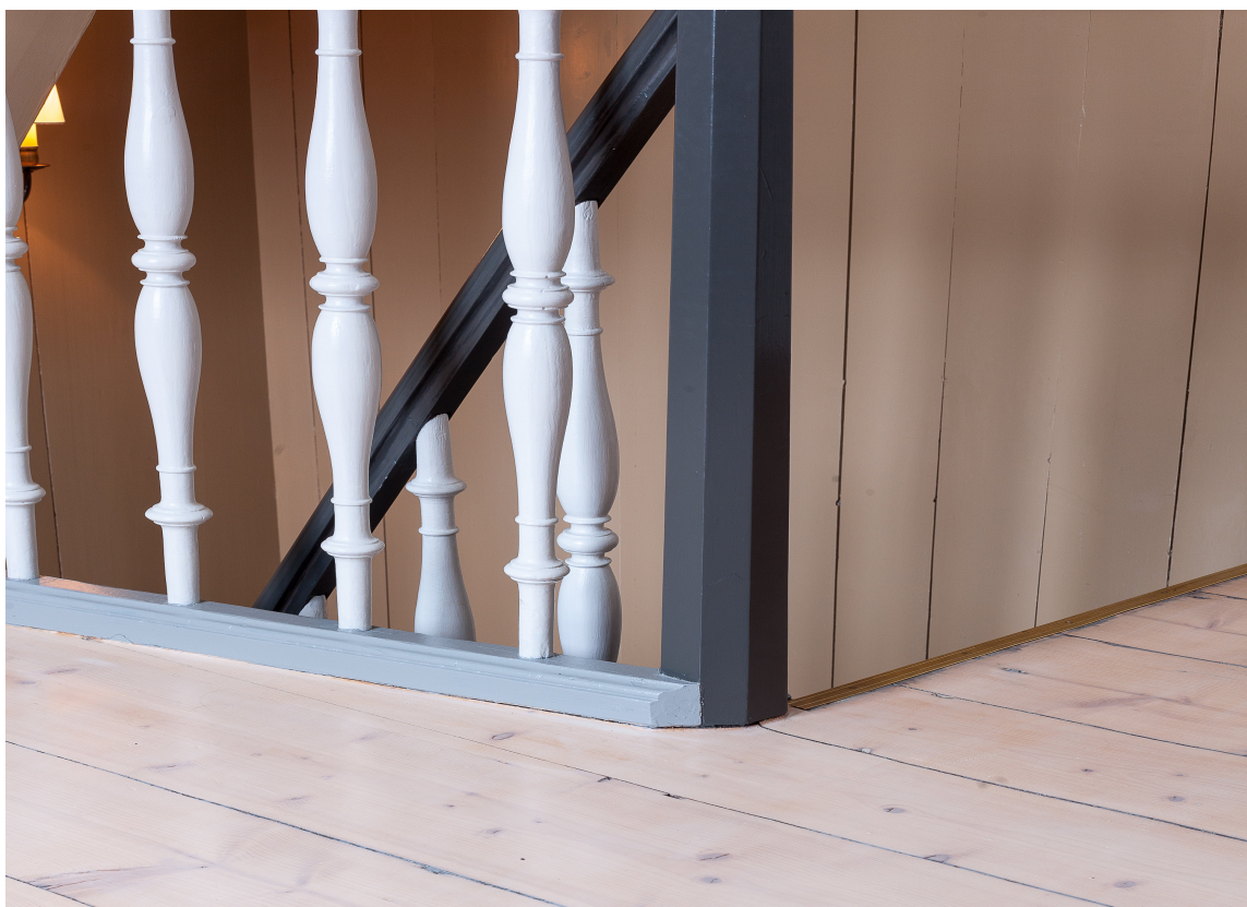
TRAPP: Den gule fargen fortsetter opp til andre etasje. Selve trappen er malt i tre grånyanser. Den mørkeste er svært viktig som kontrast. Farger: Trappetrinn S 4502-Y, Spiler S 2502-Y, Håndløper og stolpe S 7502-Y.
