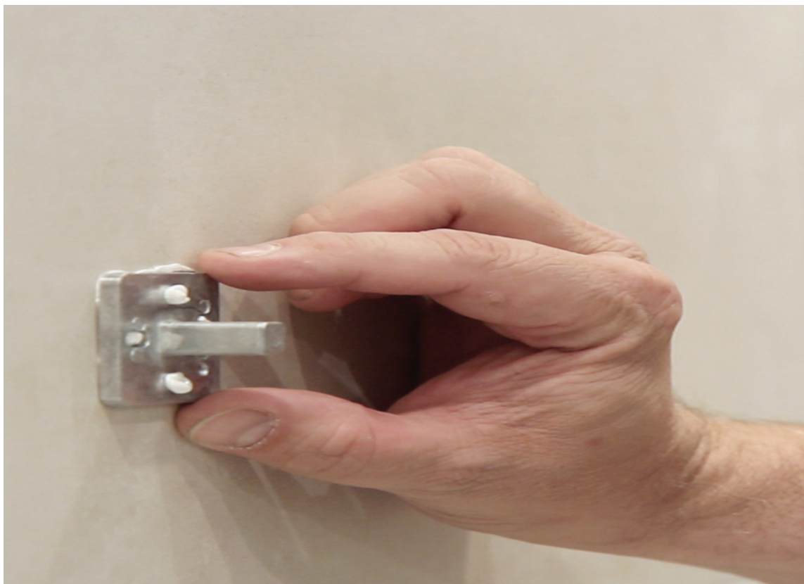
LIM: Det er enkelt å lime opp baderomstilbehøret, og du slipper å få hull i membranen.
