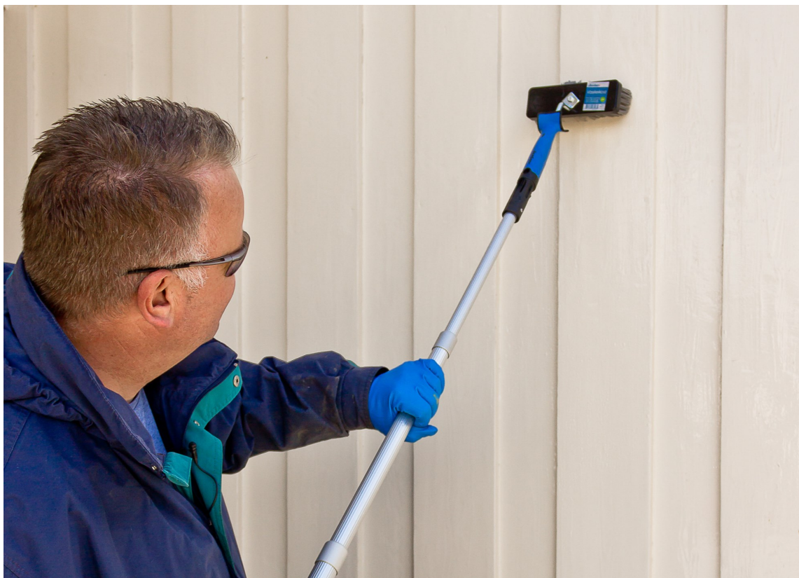
VASK: Skrub skitten vekk med en vaskekost. Sett forlengerskaft på, slik at du rekke over større felter.
