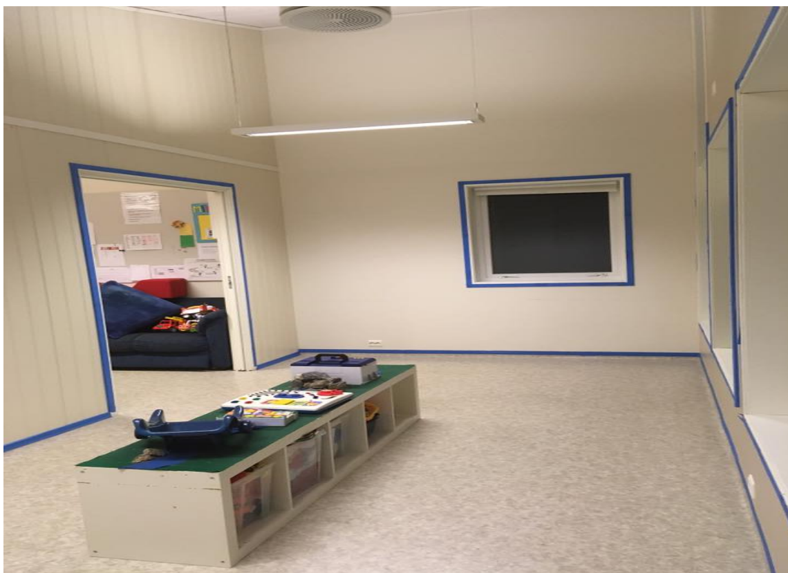
FORARBEID: Med maskeringstape rundt alle listene som skal forbli hvite, går malearbeidet unna i en fei.
