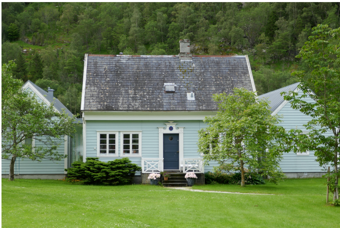
FRAMHEVE: Vakre bygningsdetaljer fortjener å bli framhevet.
