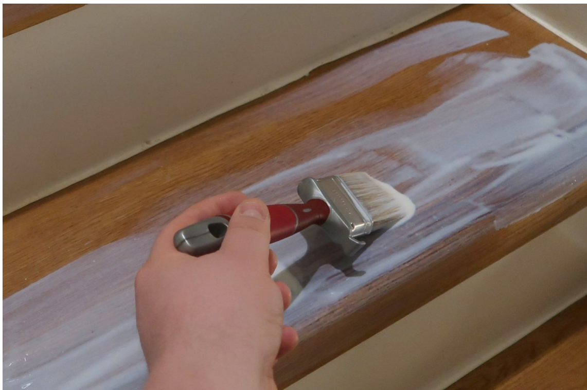
PÅ MED PENSEL: En tretrapp kan gjøres tryggere ved å påføre en ufarget lakk eller olje med antiskli-middel.
