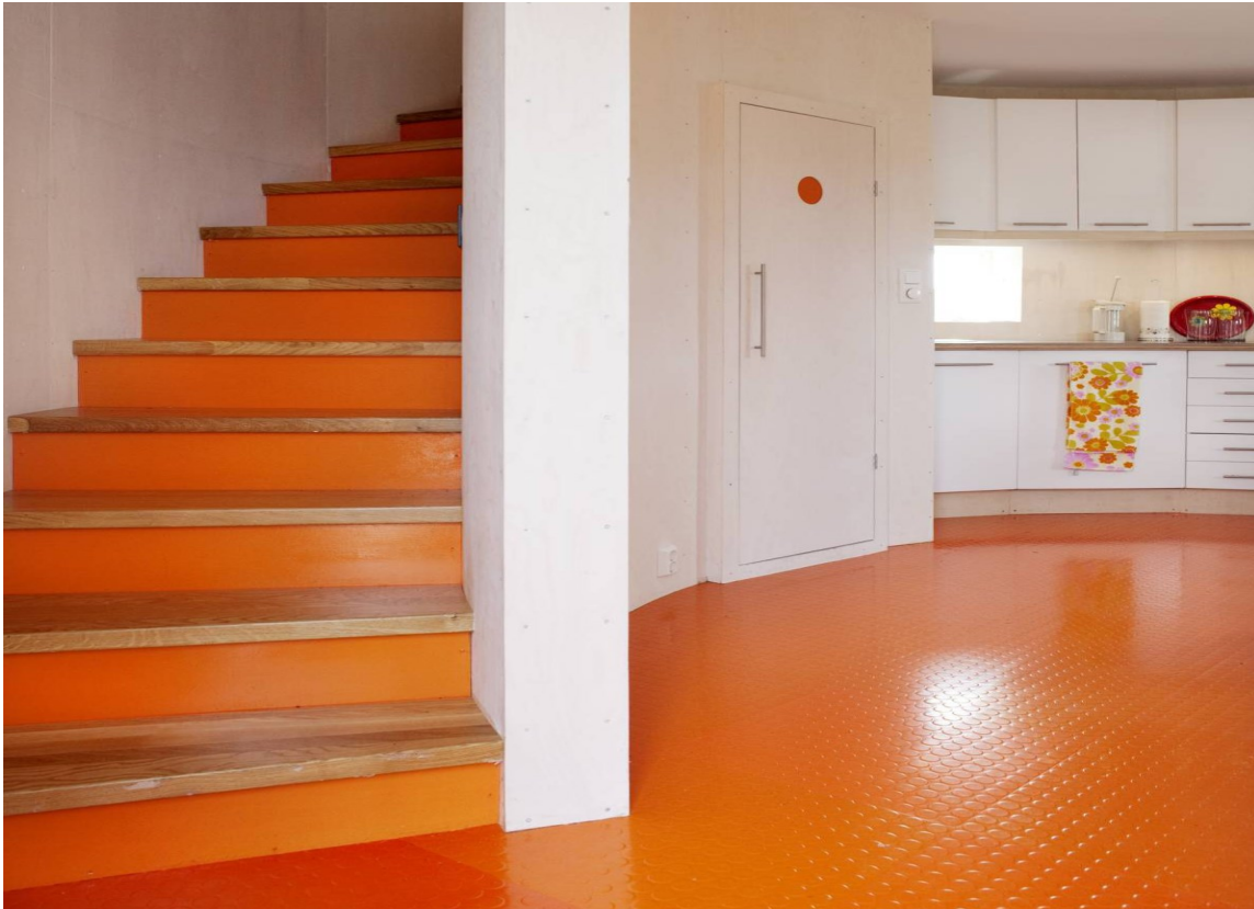
GUMMI: Belegg med struktur i overflaten, som gummigulv med knotter, kan gjøre trappen mer sklisikker.
