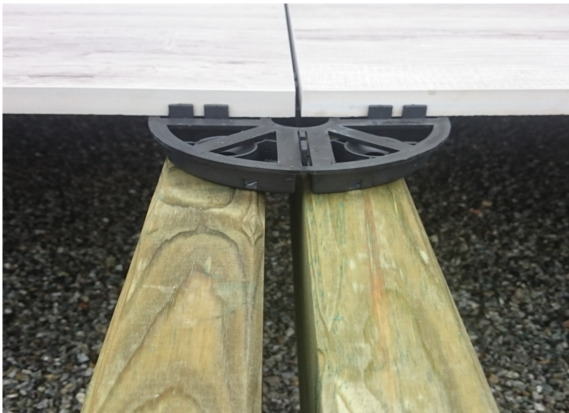
HØYDEJUSTERING: Flisene kan enkelt justeres i høyden ved installasjon. Etterjustering gjøres ved hjelp av en nøkkel.
