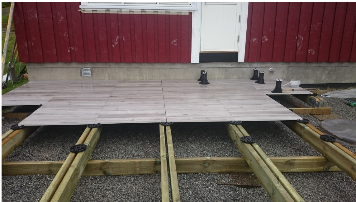
TREVERK UNDER: På grusbeddet bygges en trekonstruksjon der beina til systemgulvet festes. Hvert bein kan bære hjørnene på fire tilstøtende fliser. Høyden på beina kan reguleres, og det finnes bein som er selvnivellerende slik at overflaten havner i
