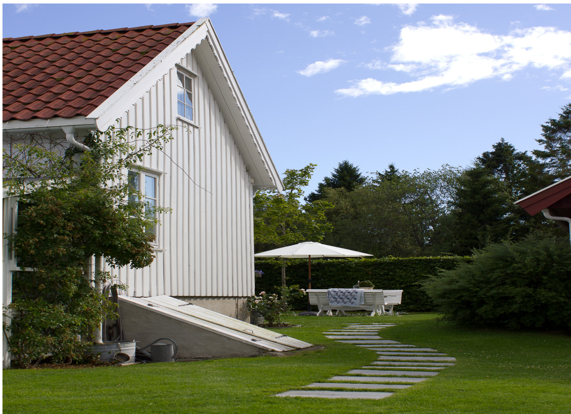
HELHET: Når gråtonen på grunnmuren er fint avstemt mot skiferheller og annen stein skaper det en naturlig helhet.
