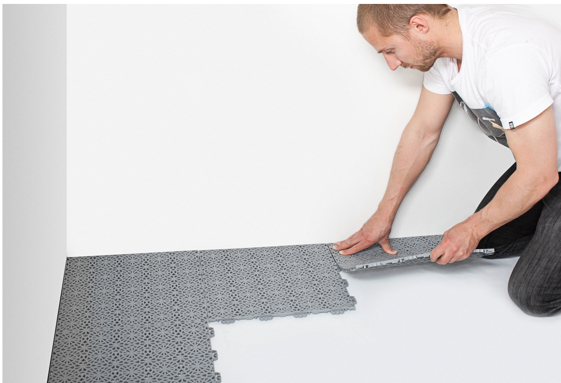
ENKELT: Plastfliser kan legges i kjellere, vaskerom, boder og garasjer – og på balkongen.
