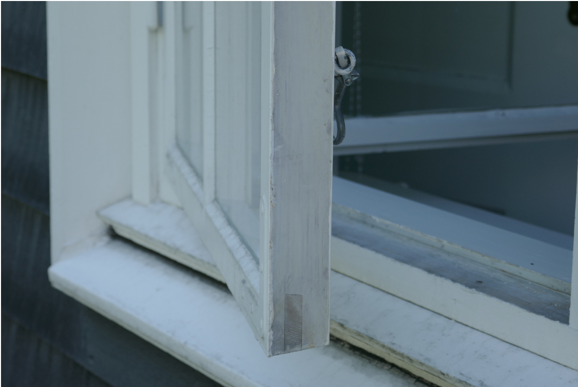
UTE: Kanten som vender ut, samt under og oppå skal males med utefargen.
