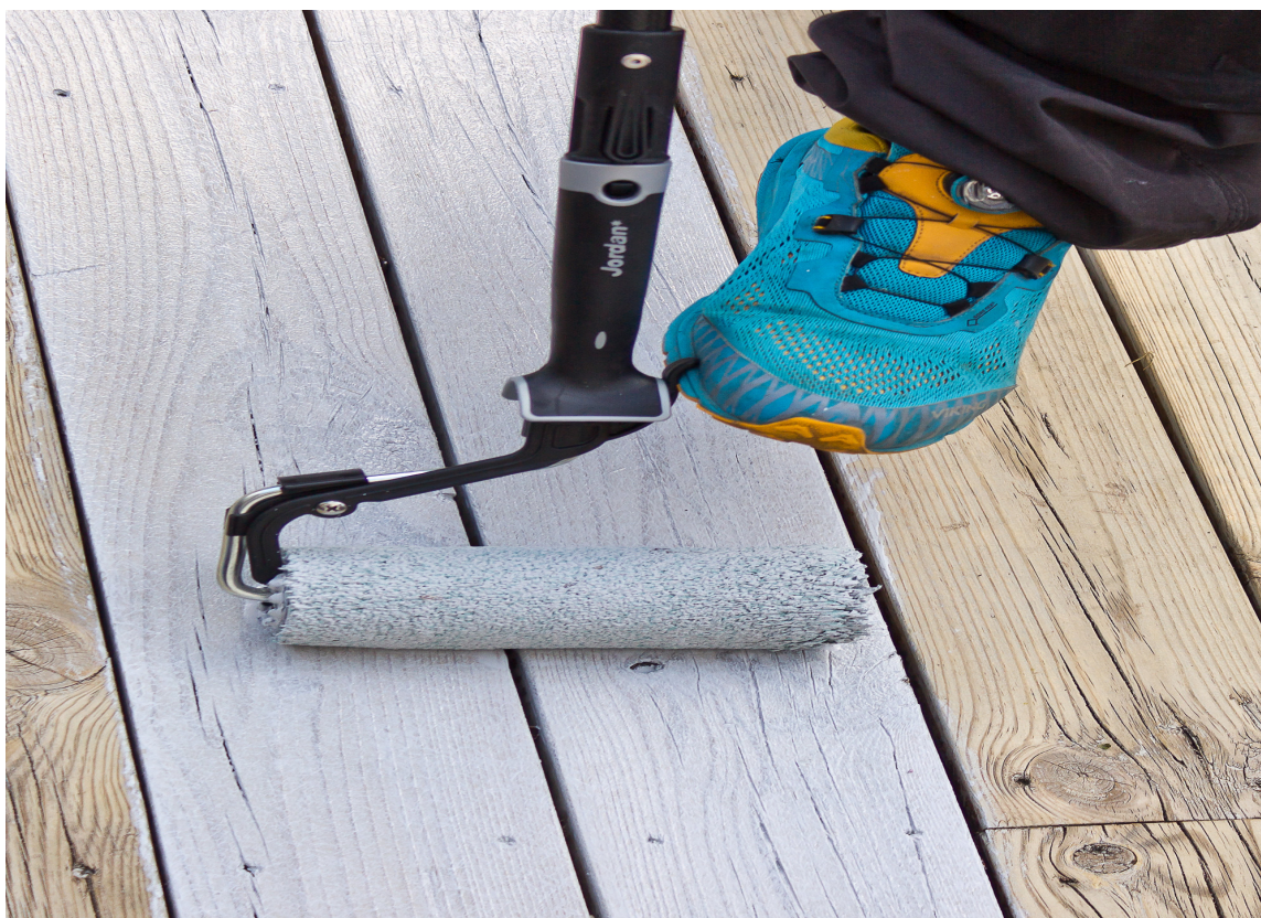
LÅSBAR: Her bruker vi en låsbar rull som også fungerer som fordriver.
