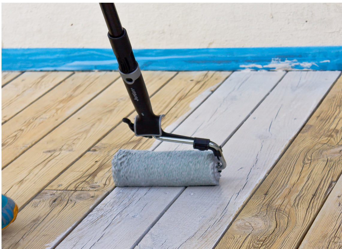
BEIS I VEI: Arbeid over et par bord av gangen og påfør beisen vått-i-vått.
