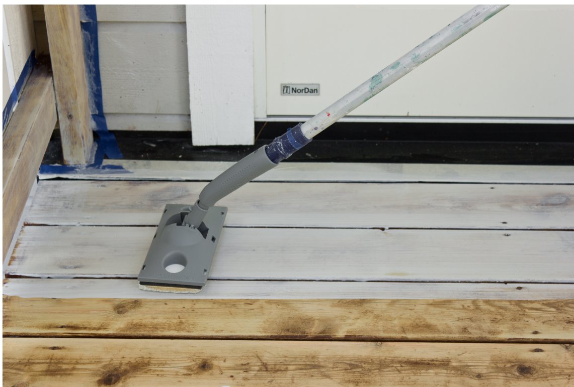
UNDERLAGET PÅVIRKER: Beis er en transparent behandling som lar underlagets utseende sette preg på sluttresultatet.
