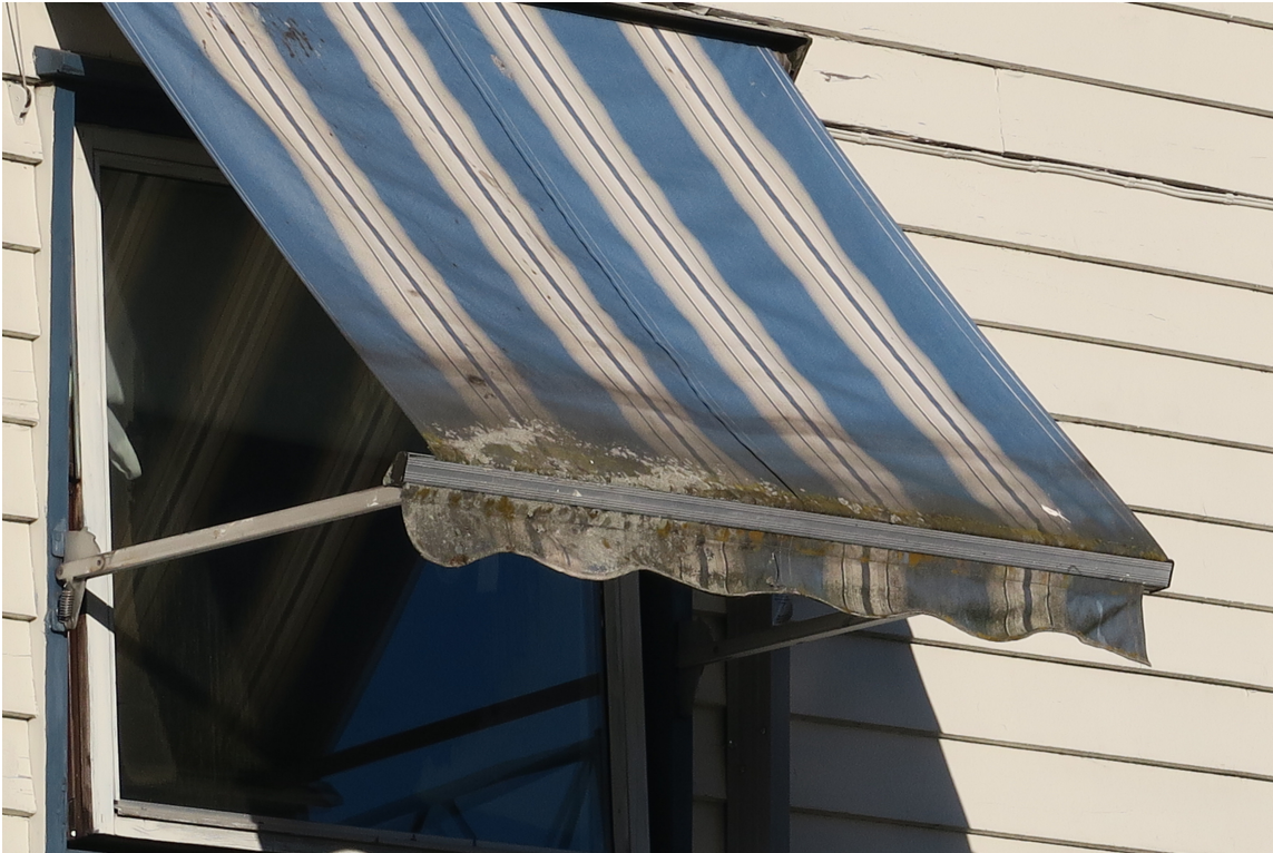
TRENGER VASK: Sur nedbør og smuss tærer på norske markiser. For at de skal holdes pene, må de vaskes sommer og høst.
