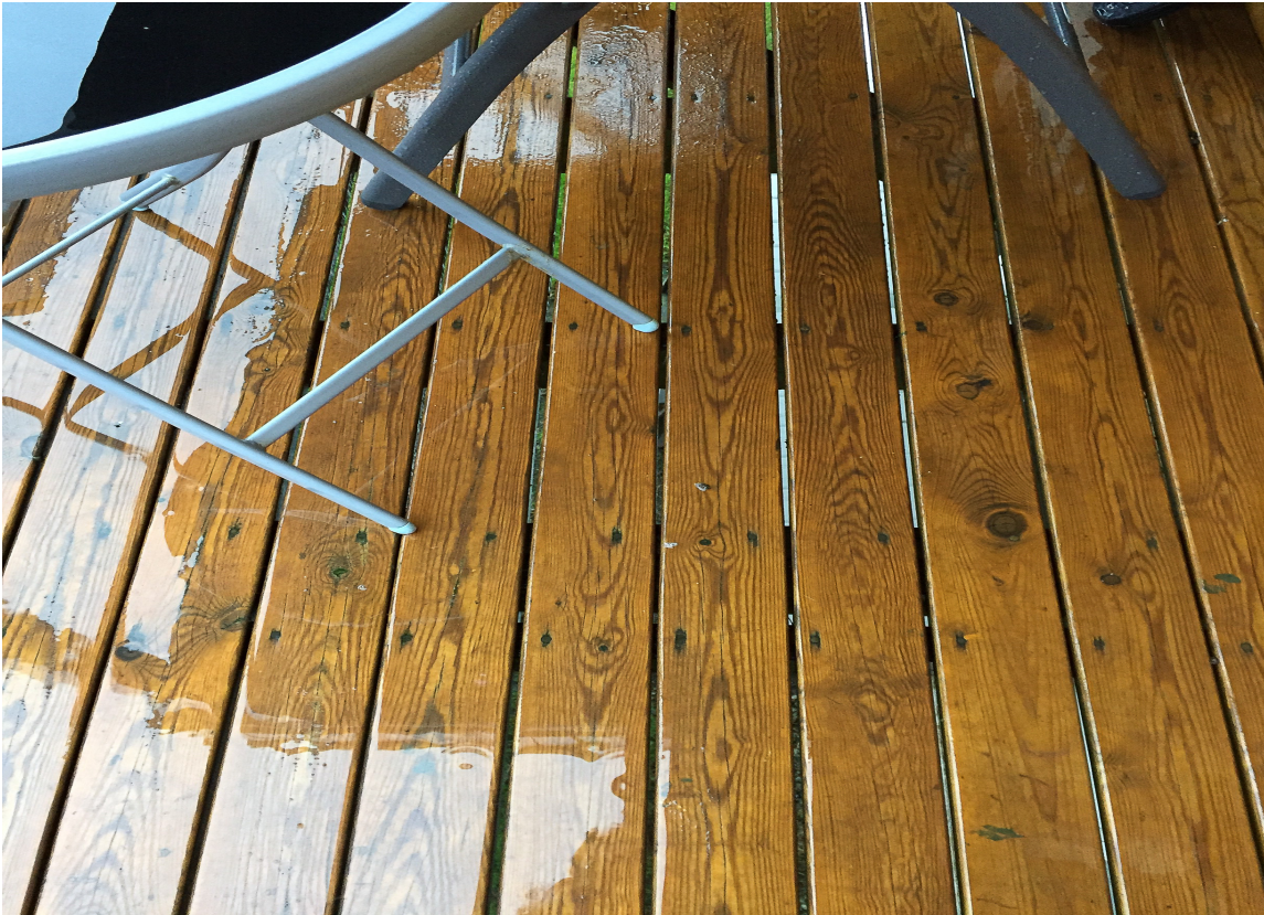
BEVARINGSVERDIG FARGE: Terrassen ble første gang behandlet i 2010 med Tyrilin Terrassebeis i fargen Gaupe Den er fortsatt lys, etter å ha fått 4-5 strøk opp gjennom årene.
