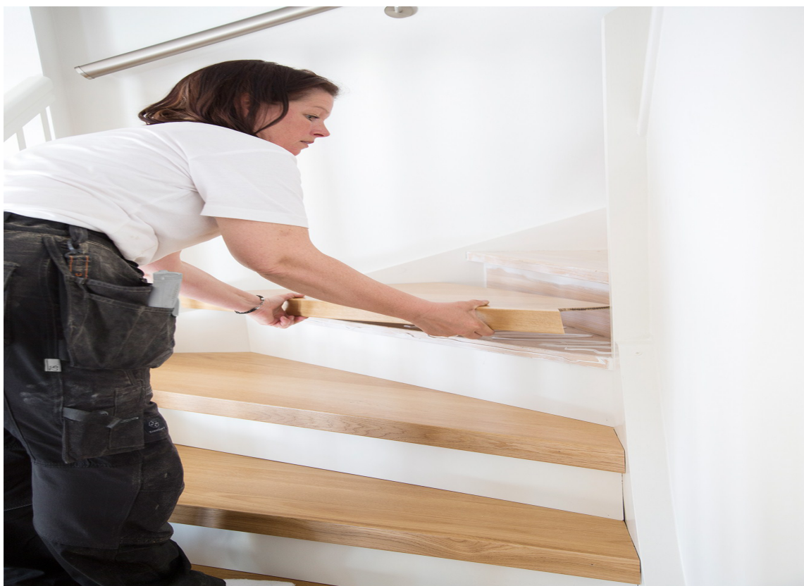
NYE TRINN: Ved å montere nye trinn oppå de eksisterende, får du raskt ny trapp.
