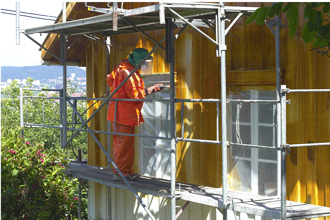
STILLAS: Ta taket samtidig som stillaset er oppe.
