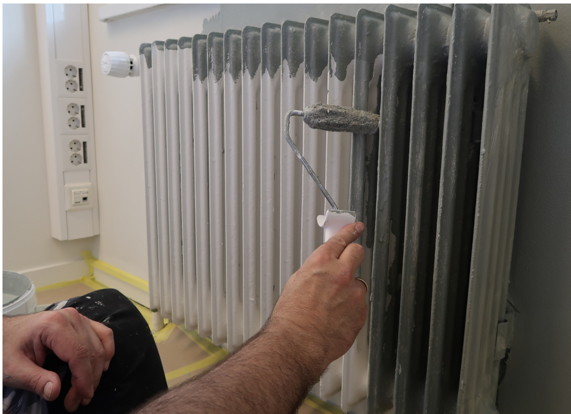
NY MED MALING: En gammel og slitt radiator blir som ny med litt maling.
