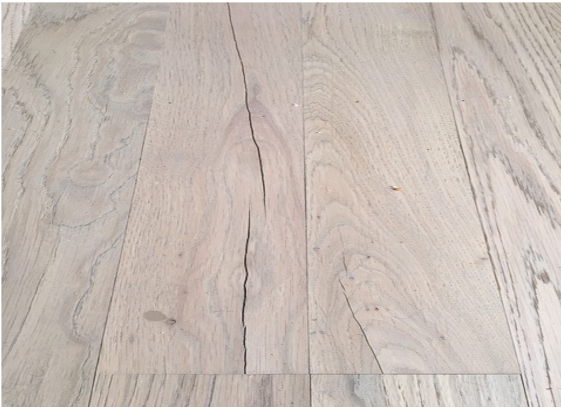
BEGRENSES: Problemet med sprekker i tregulvet kan minimeres ved å tilføre naturlig fuktighet i rommet, og ved å ha kontroll på klimaet.
