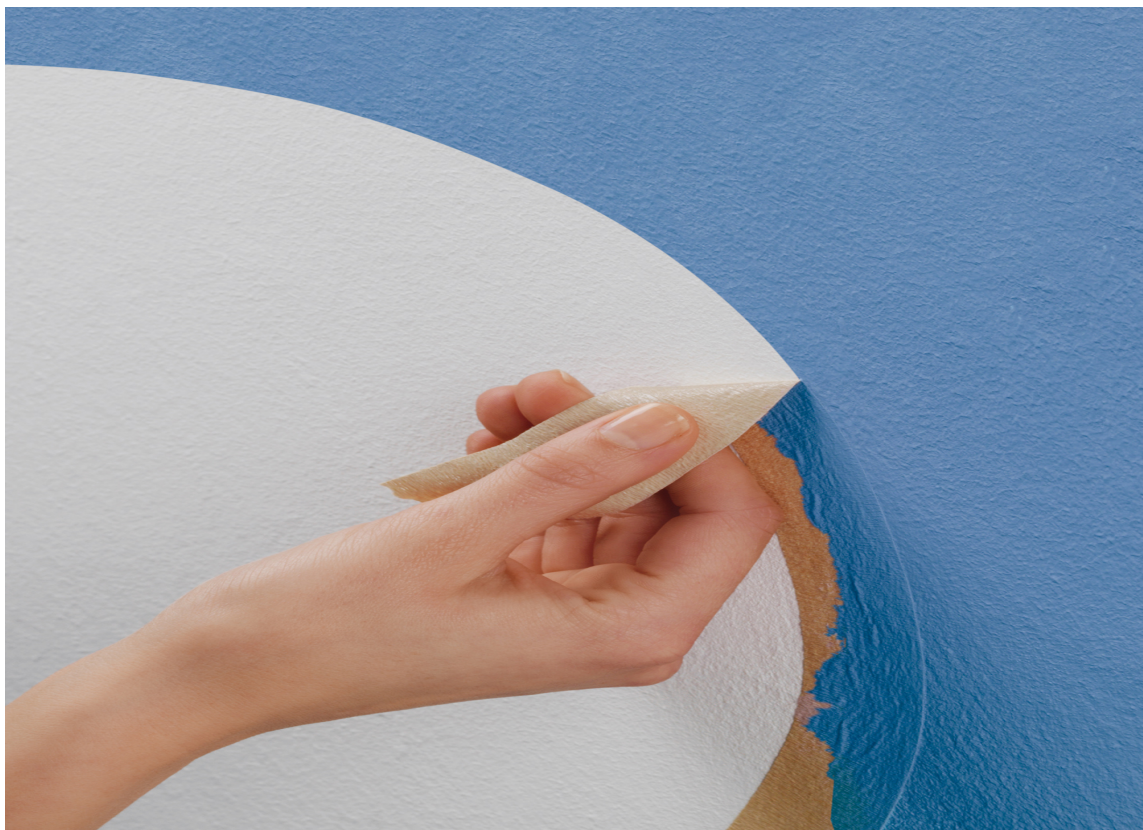
MAL RUNDT: Det skarpe skillet mellom malt og ikke malt, trenger ikke å være rett. Bruk spesielt fleksibel tape for kurver.
