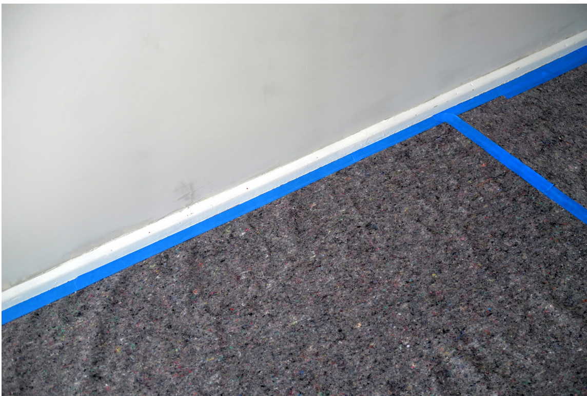
TAPE TIL JOBBEN: Når lister skal maskeres er det smart å bruke en tape som ikke ødelegger underlaget. Det er også lurt å legge malerfilt på gulvet. (Foto: Robert Walmann/ifi.no)
