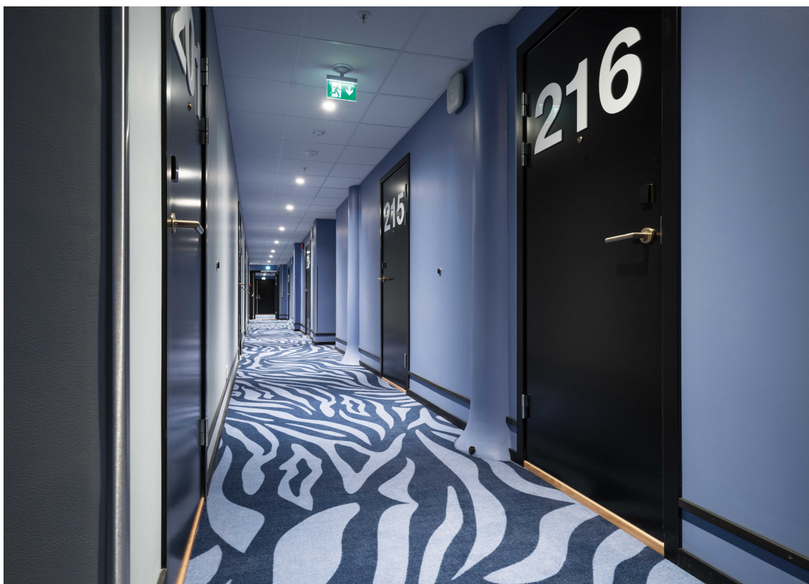
LISTER: Vegger og lister på hoteller utsettes for røff bruk. På flere hoteller i kjeden er det gjennomfargede lister av høy kvalitet, fra Deco Systems. De tåler det meste, og evt. merker vil ikke synes, da fargen går hele veien gjennom listene.
