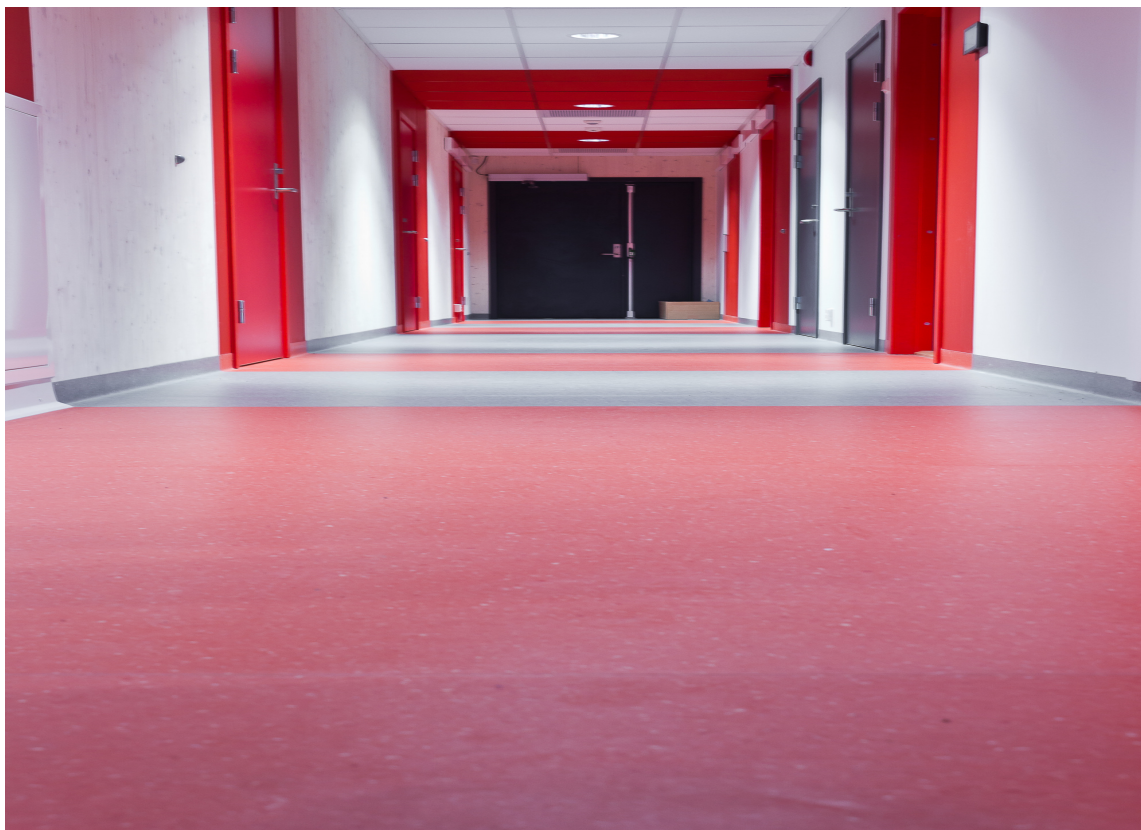
STILLE: I korridorene brukes et PVC-fritt akustikkulv. (Foto: Chera Westman/ifi.no)
