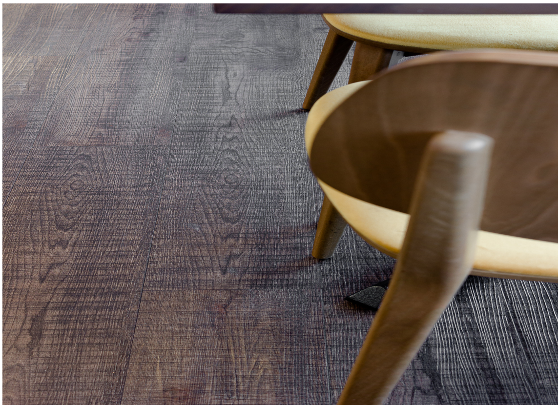
RUSTIKT: Designgulvet har naturtro tekstur og utseende. – Gulvet kan legges løst uten fast forankring til underlaget. I dette tilfellet ønsket vi likevel å bruke et fikseringslim som skaper noe forankring.
