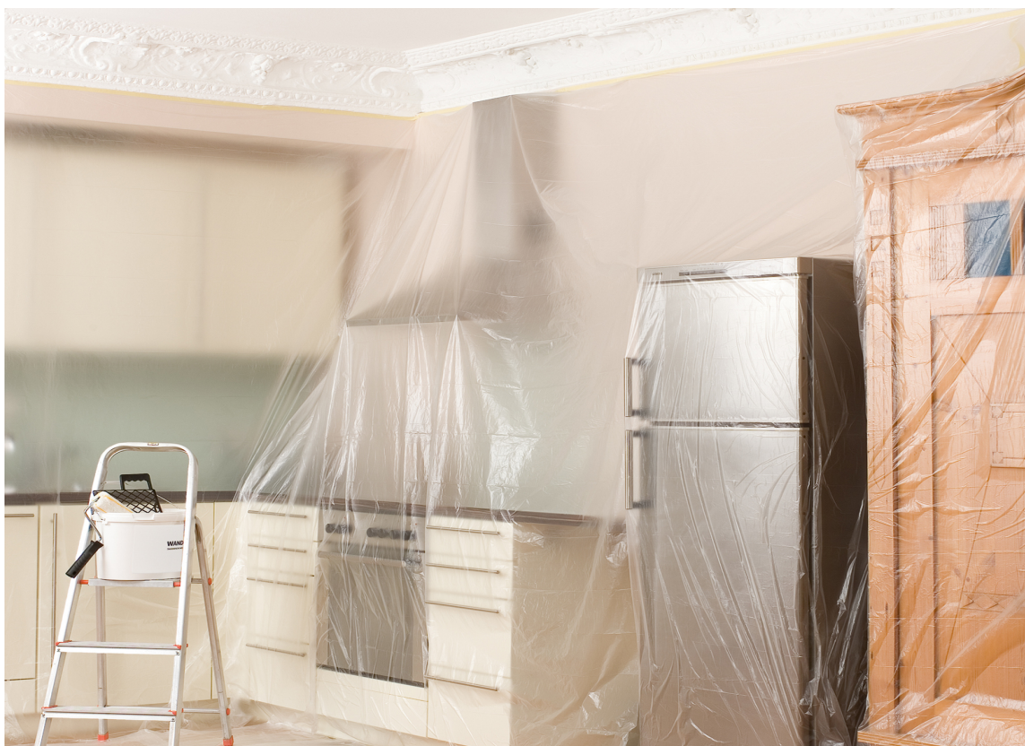
DEKKEPLAST: Dekkeplast med statisk elektrisitet egner seg særlig til å dekke fast innredning og vegger. (Foto: Jordan)
