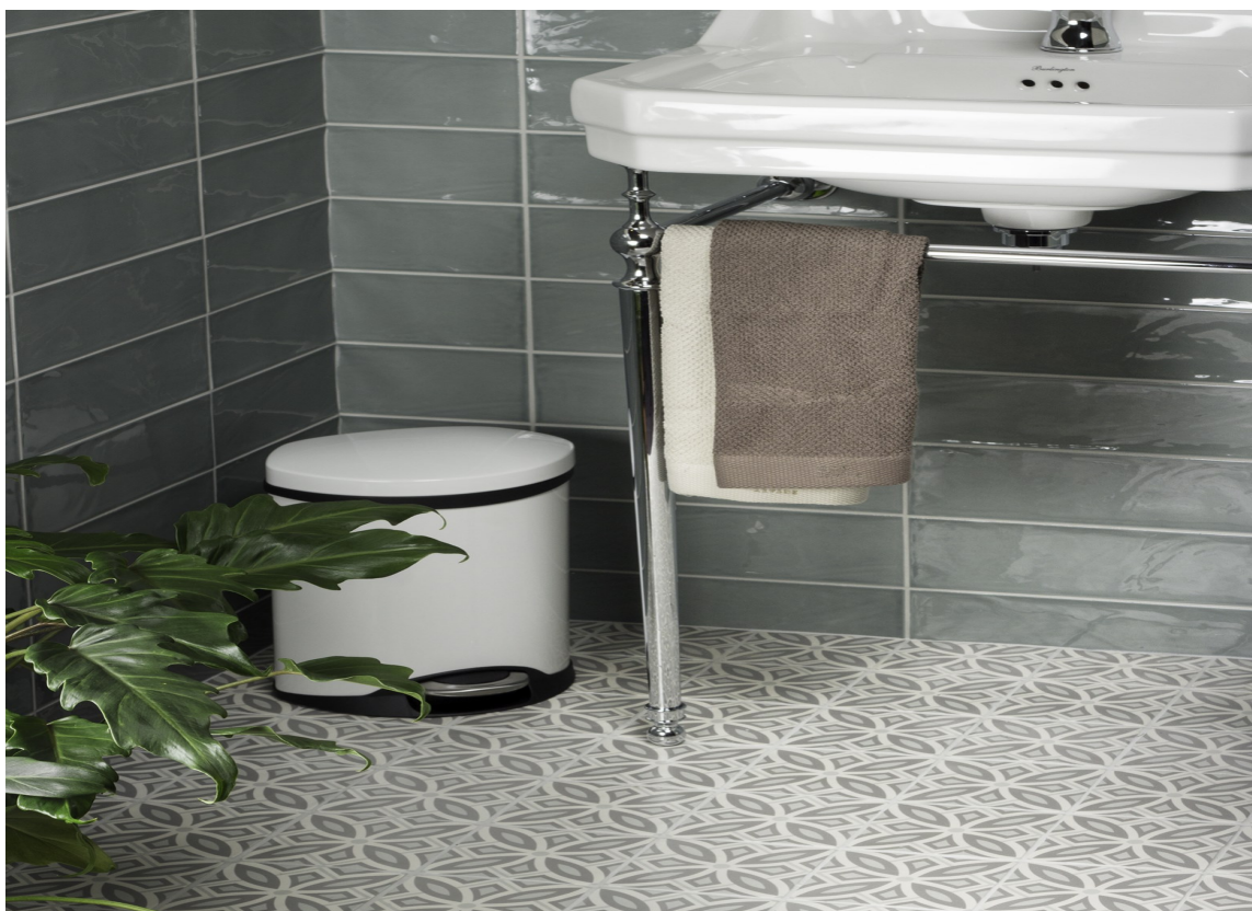
SKLISIKKERT: Flisgulv med mange fuger er sklisikkert. Fugene er ru i overflaten og gjør at du trår sikker også da gulvet er vått. (Foto: Golvabia)
