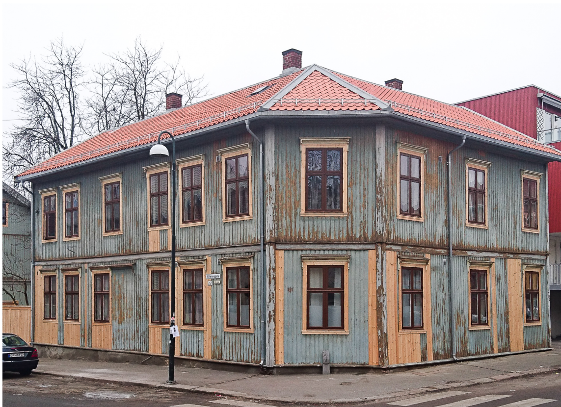
UNDERVEIS Løs maling er fjernet og husene er ferdig skrappt, for hånd. Dårlig panel er erstattet av malmfuru og nytt tak er lagt. Mye av den gamle malingen fikk være, som et historisk vitnesbyrd. (Foto: Boligbygg Oslo KF)
