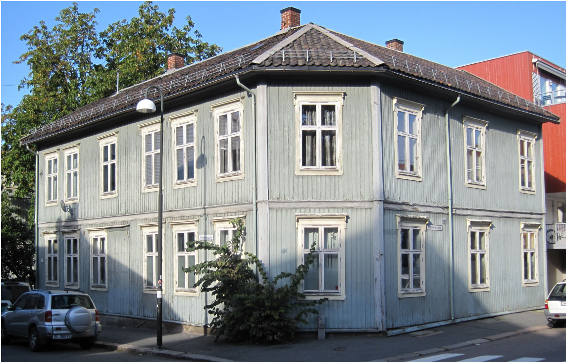
FØR Vinduer og tak var i dårlig stand, deler av panelet hadde råte og treverket nærmest ropte om hjelp. (Foto: Boligbygg Oslo KF)
