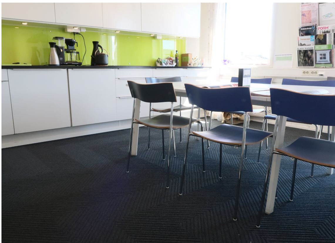
DE VONDE LYDENE: På møterommet til Studio NSW på Hamar var lydforholdene svært dårlige. Løsningen ble å legge Desso «SoundMaster» fra Tarkett. Dette er teppefliser med ekstra tykk bakside som demper romklang og akustikk.
