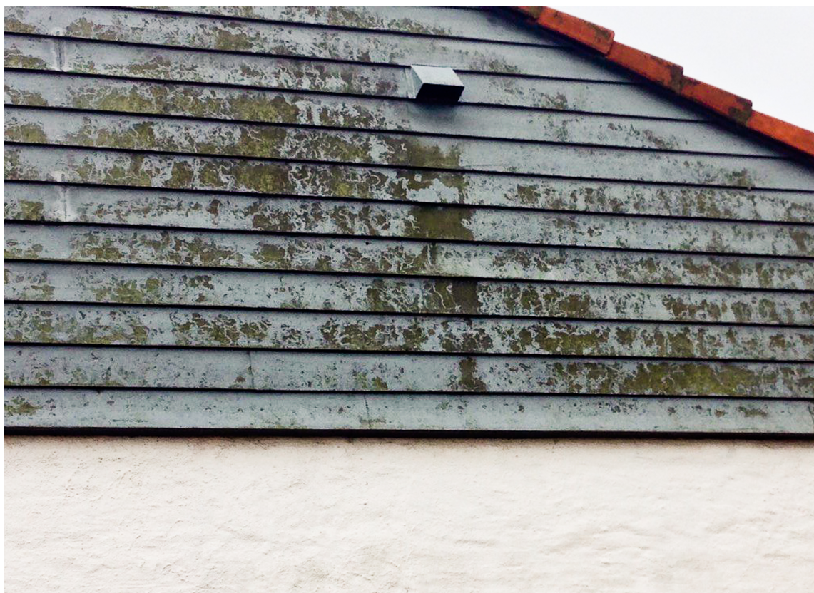
BEGROING: Alger og svertesopp trives godt på oljebaserte malinger, slik som linoljemaling og alkydmaling.
