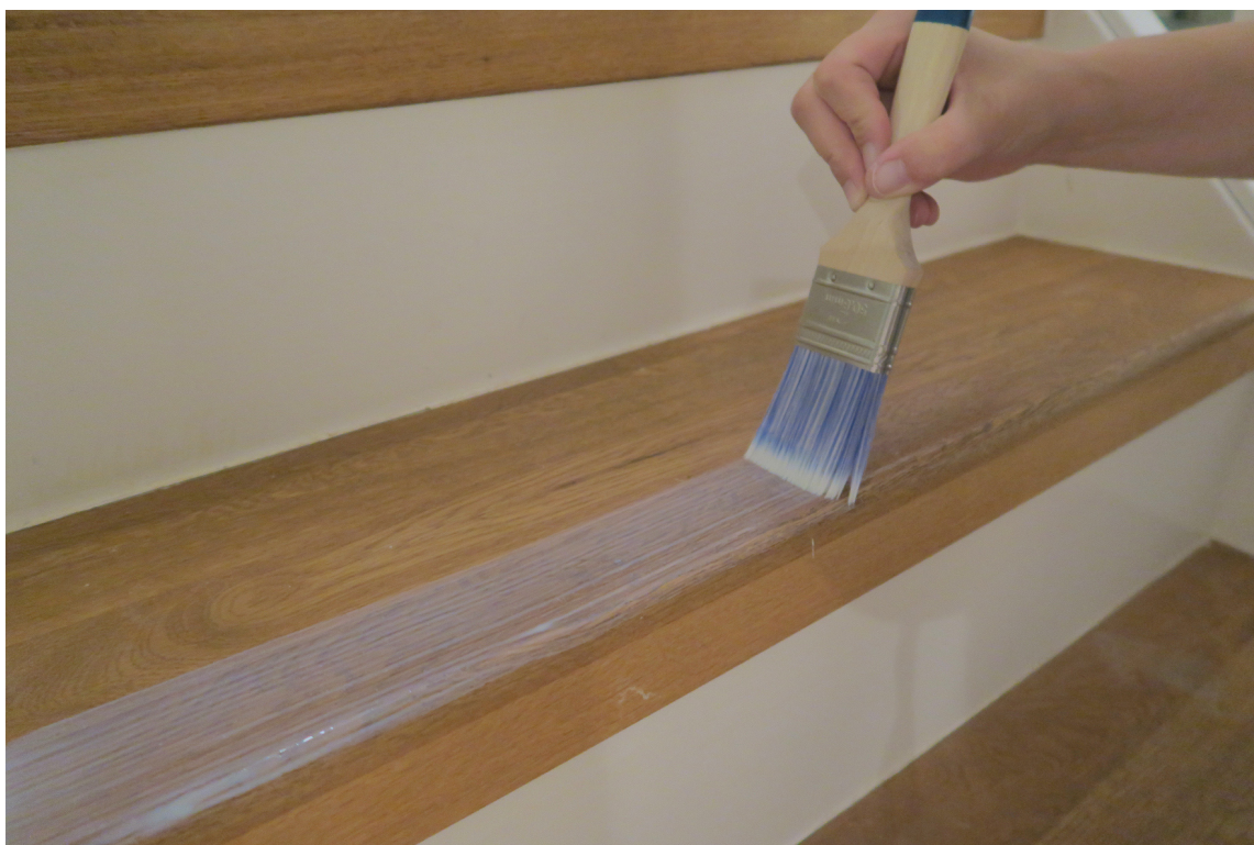
SKLISIKRING: Malte og lakkerte trappetrinn kan påføres et transparent sjikt med sklisisikring. Det går også å blande inn sklisisikringsmiddel i malingen eller lakken. (Foto: Robert Walmann/ifi.no)
