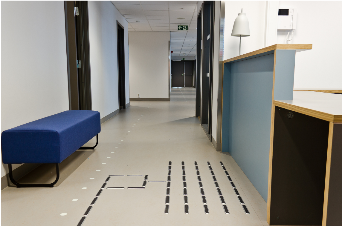
TAKTIL MERKING: I gulvet er det felt inn både taktile ledelinjer og markeringer av rømningsveier som blir selvlysende i mørket. Kapsel Design har utformet arbeidsskranker og faste stasjoner i bygget.
