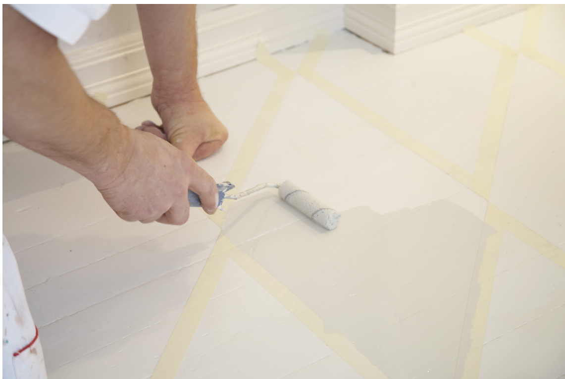
RULL: Bruk gjerne en liten rulle til å male mellom maskeringstapen. (Foto: Kristian Owren/ifi.no)
