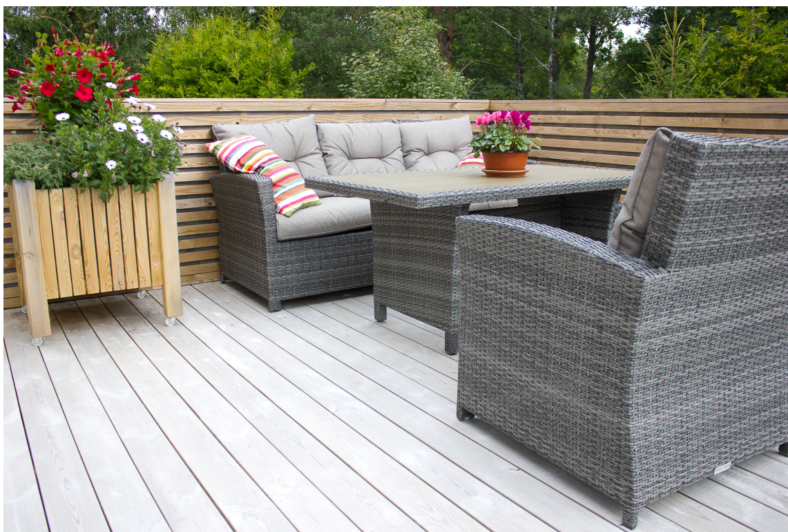
FARGEENDRING: Behandlingen beskytter treverket i mange år og gjør det grått, flisefritt og behagelig å gå på. (Foto: Bjørg Owren/ifi.no)
