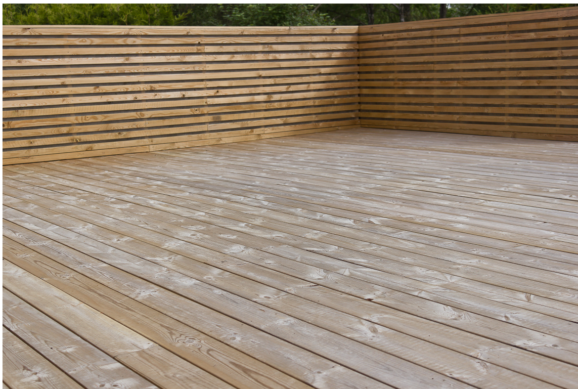
FØR: Noe måtte gjøres. Terrassen trengte overflatebehandling. Hverken farge eller holdbarheten var optimal. (Foto: Chera Westman/ifi.no)
