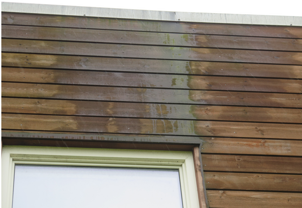
TAKUTSPRING: Når taket stikker ut 20-30 centimeter eller mer utenfor fasaden, forhindrer det at regnvann renner langs veggen og fukter treverket. (Foto: Mycoteam)
