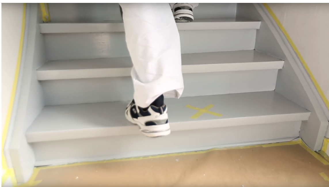
TØRT: Ved å feste tapen på trinnene du maler først, vet du hvilke trinn som er tørre og som derfor også er trygge å bruke.
