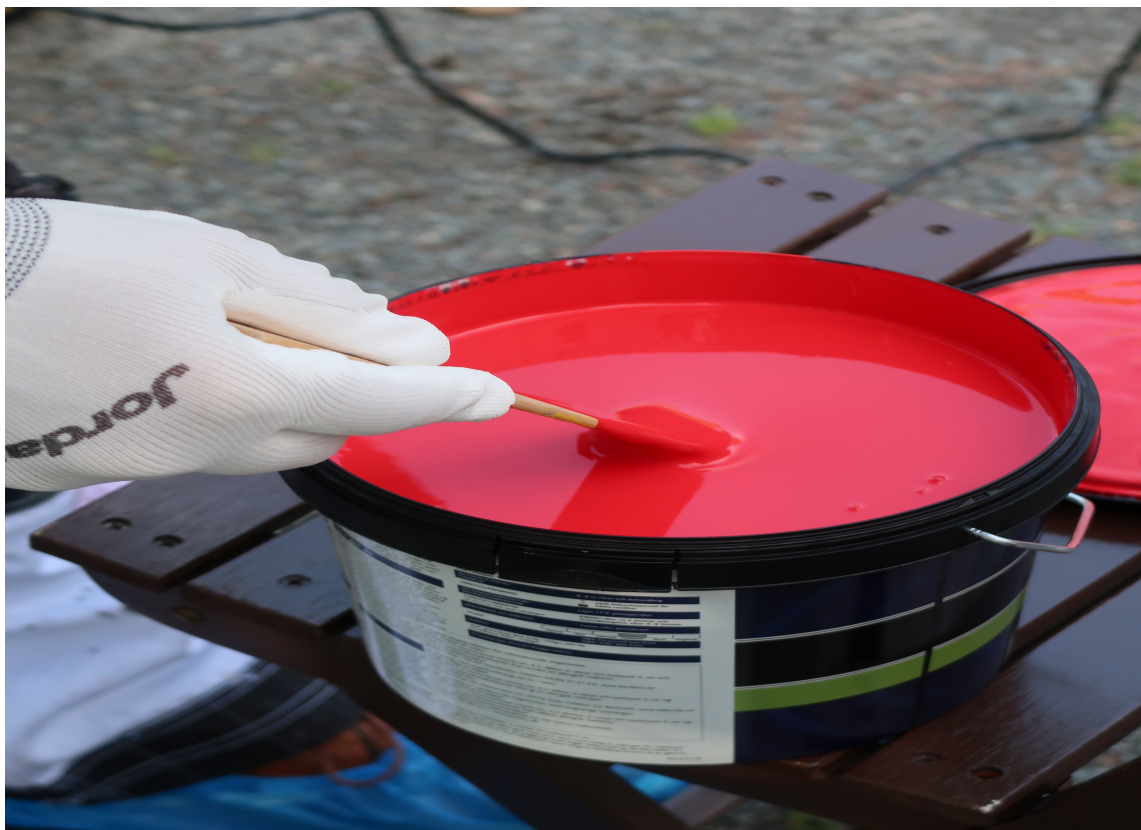
BARE RØR: Lars Petter Rustan fra Orka Housecare mener folk må røre mer. – En maling som er godt blandet vil gi det beste resultatet, sier han. (Foto: Robert Walmann/ifi.no)
