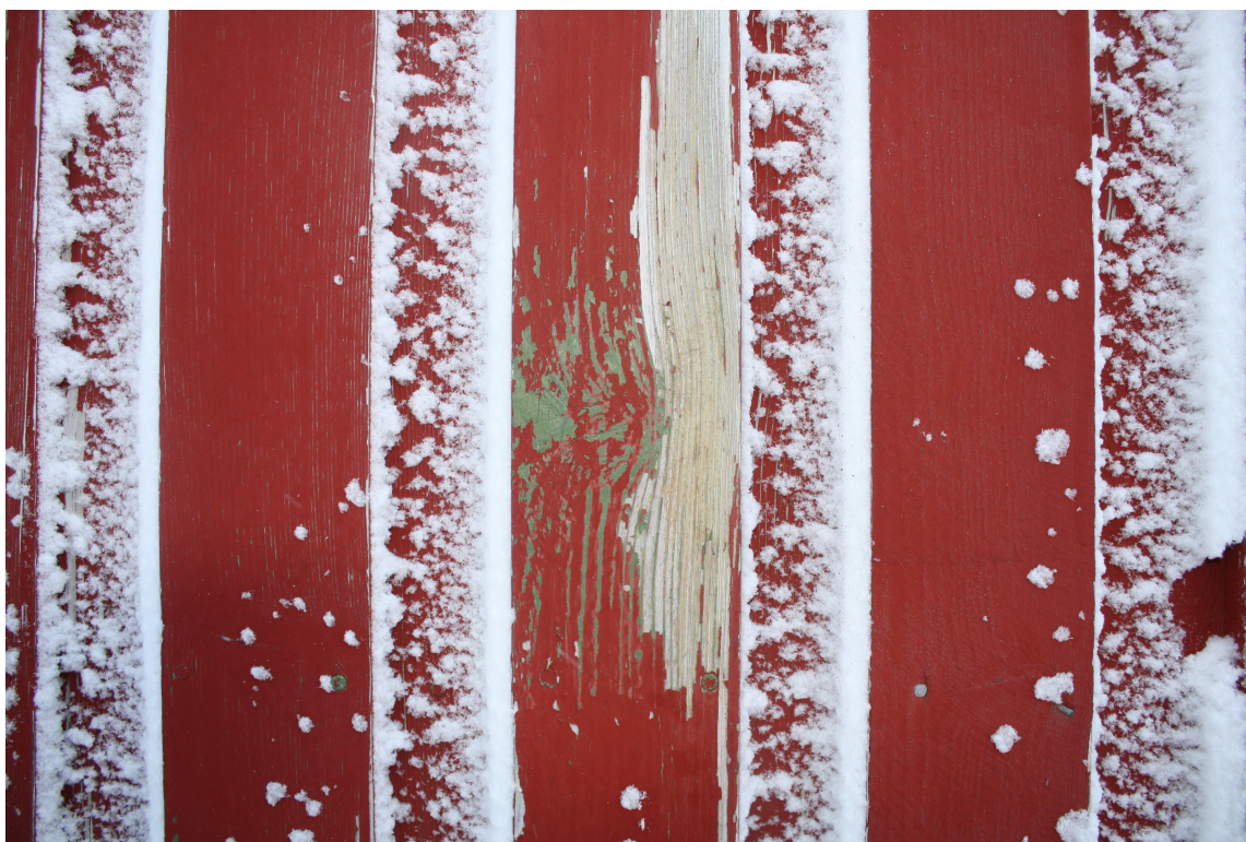
SOM NYTT: Solen sliter hardt på fasadene. Men under eksisterende malingsjikt og død ved, var underlaget nesten som nytt. (Foto: Per Myhre/Nordsjö)
