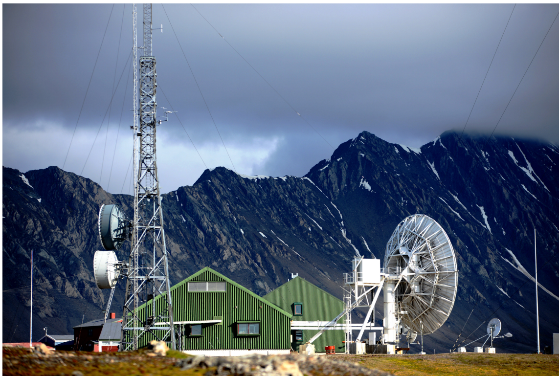
BEBYGGELSEN: Det er til sammen syv bygninger på eiendommen. Noe har fasade i betong, andre fabrikkmalte metallplater, men de fleste har trefasade. Driverne av stedet ønsker å skifte ut platefasader med trekledning. (Foto: Basecamp Explorer)
