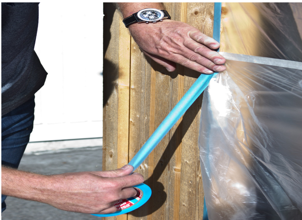
DEKKEPLAST: Dekkeplast med statisk elektrisitet klebrer seg til flatene og dekker godt.
