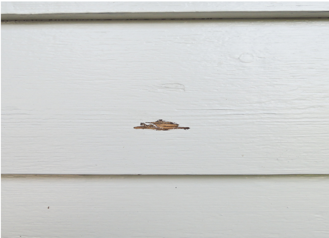
UFORSIKTIG: Når du ikke er forsiktig ved stabling av ved, blir det fort småskader i filmen. (Foto: Chera Westman/ifi.no)
