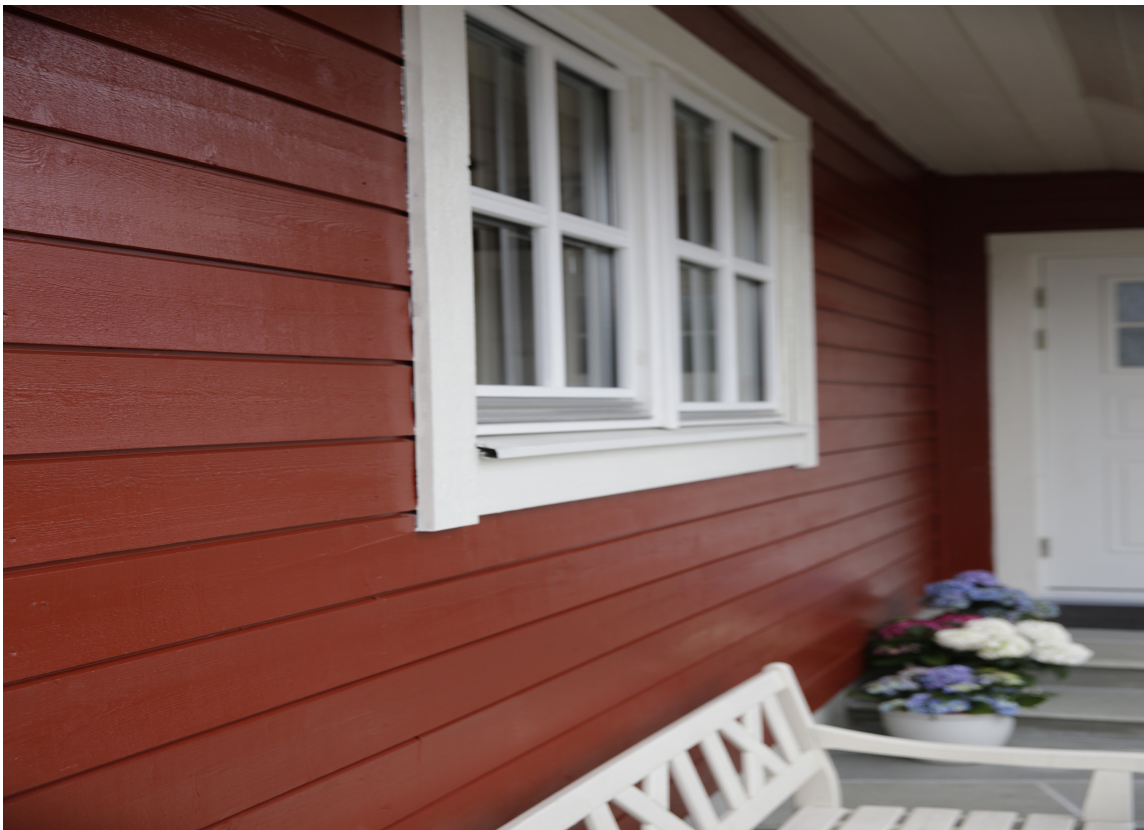
HUSK DETALJENE: Gi endeveden og undersiden samme behandling som resten av vinduene. (Foto: Butinox)
