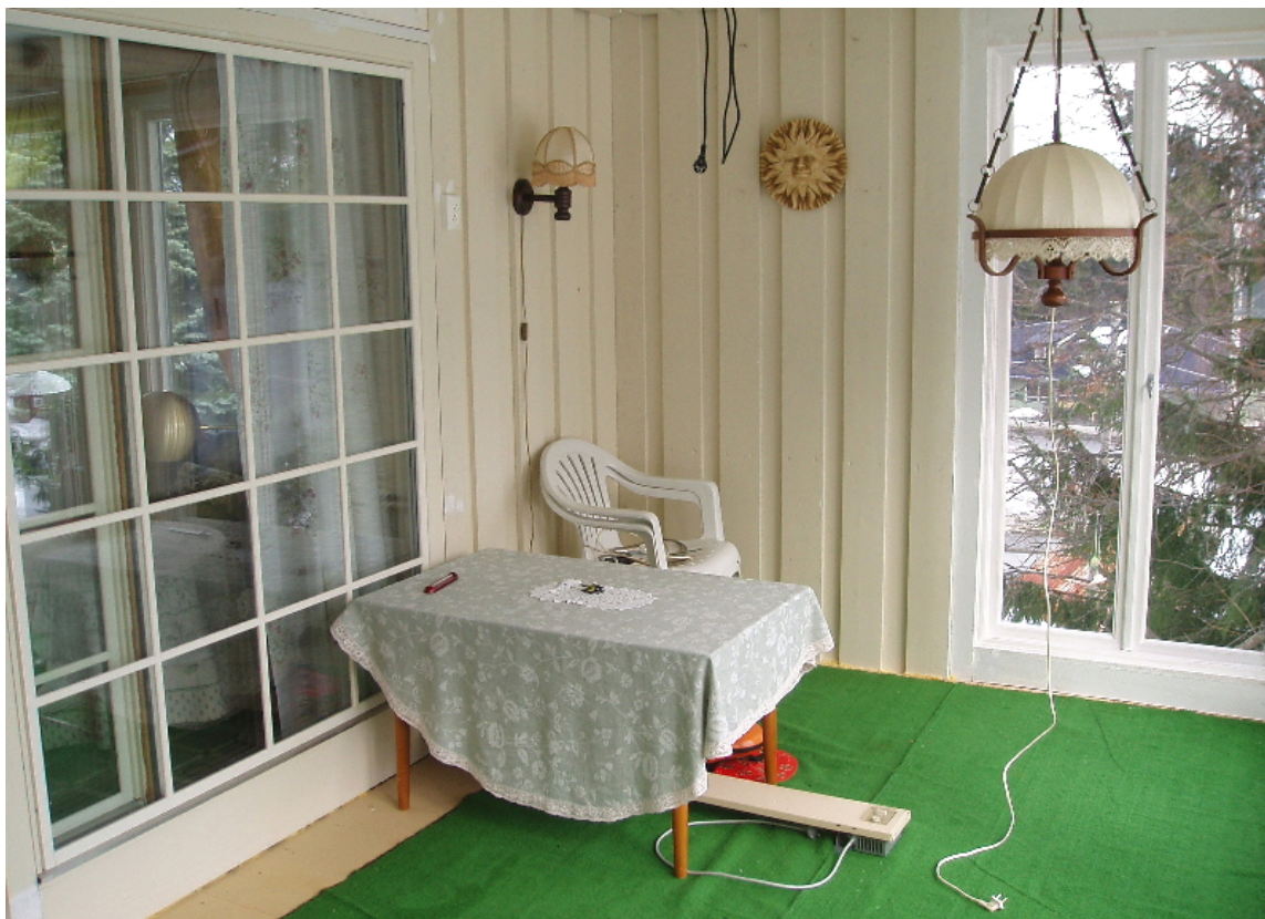
UNDERVEIS: Her har vinduene kommet på plass. Den gamle terrassedøren er i bruk, og åpnes mellom de to stuene.
