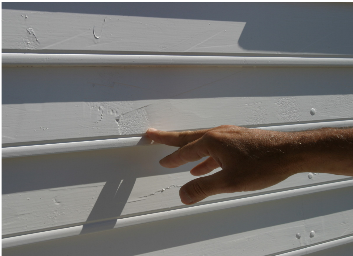
SJEKK: Når huset er rent, er det klart for å sjekke om det er løs maling eller andre skader som skal fikkes på. (Foto: Kristian Owren/ifi.no)
