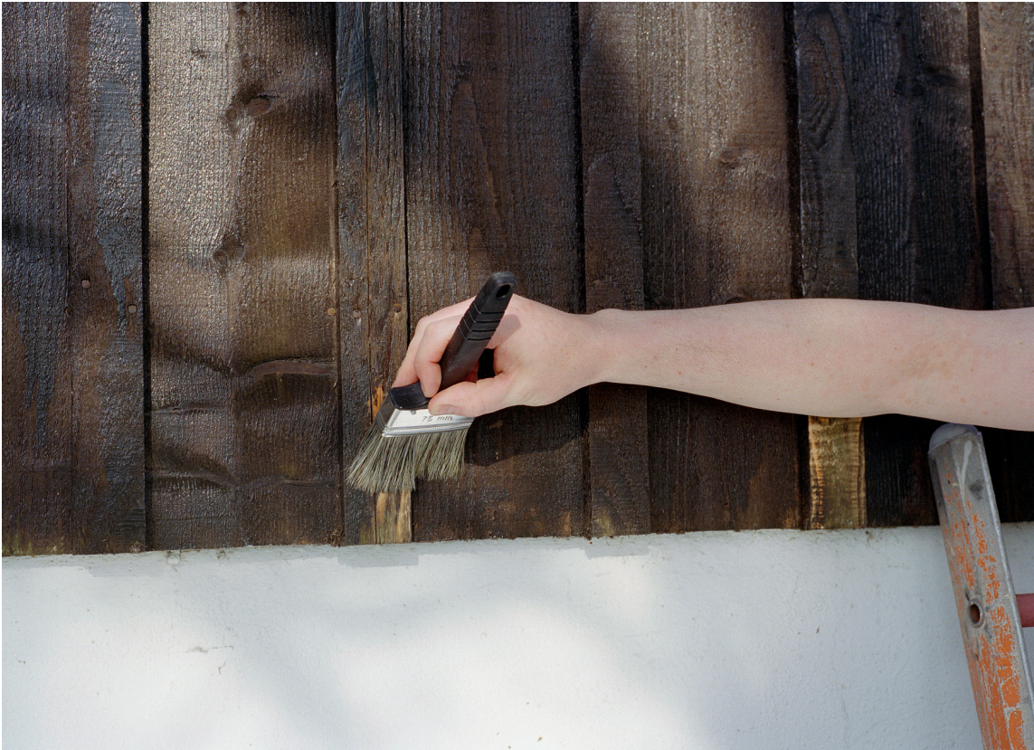
GRUNNING: Bart tre må grunnes før det beises eller males på nytt. (Foto: Nordsjö)
